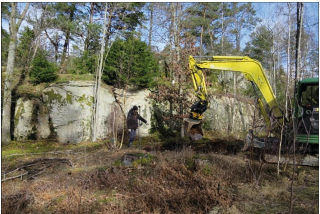
Figur 15. Schaktning i de södra delarna av Boplatsläge 3. Foto mot N.
