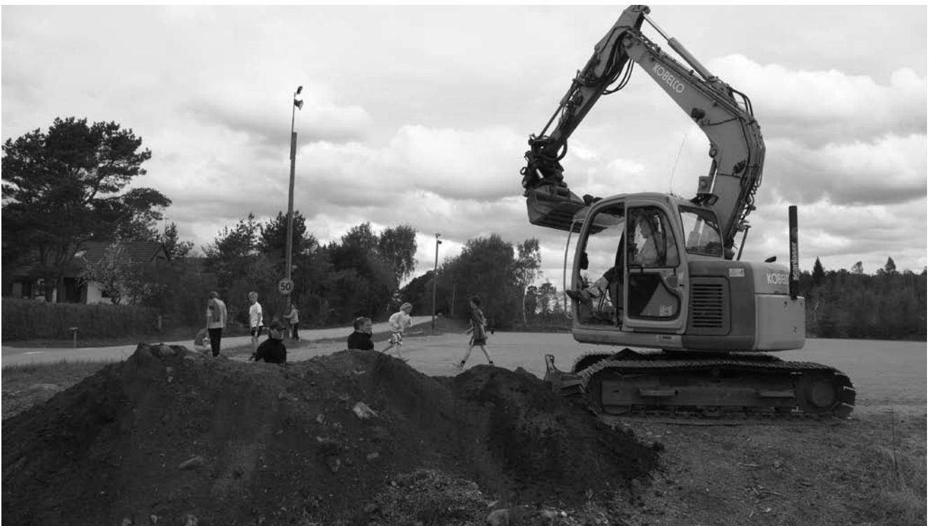
Ill. 6. Anders och Petra undersöker schakt 10, i södra kanten av Hagavallen.
