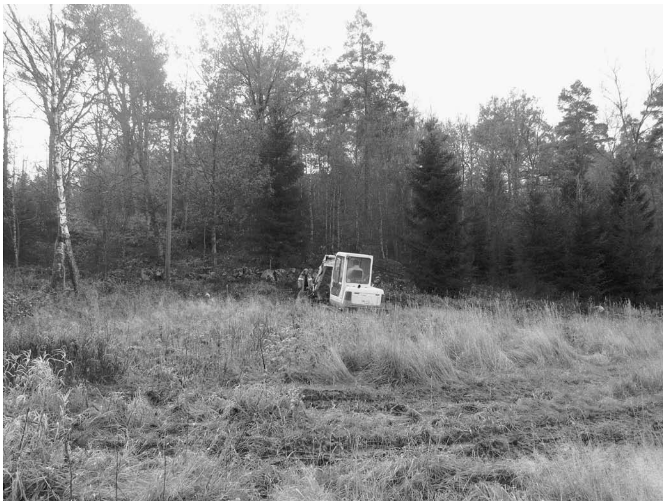
III. 5. Översikt över Angered 54, mot söder.
