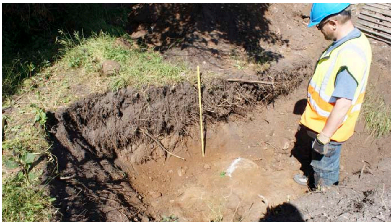
III. 17. Översikt över schakt 10 vilken tydligt visar humösa lager, mot NO. På bilden även Mats Sandin.
