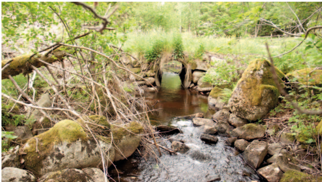
Illustration 19. Lämning 1114:17 är resterna efter en mindre kvarn. Bäckens kantning är fortfarande kantad av stenar som format en ränna. Dammvallen är raserad men utnyttjas idag som en del av en kulverterad övergång över bäcken.
