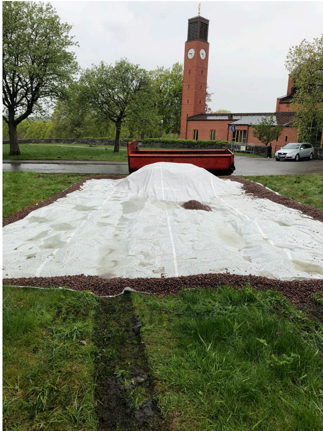
Figur 4. Foto över området som skadats av oljespill, täkt med markduk. Foto mot nordväst.
