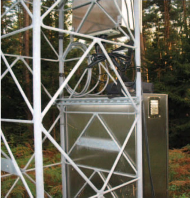
Illustration 2. Boxlokal 1. Bild på autoboxen kopplad till mikrofonen i vindmasten.
