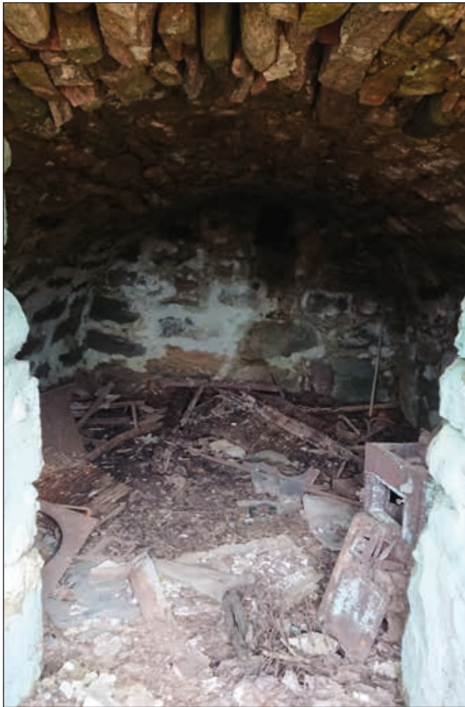
Figur 11 (t. v). Foto visande det mycket vällagda valvtaket i torpets jordkällare. Foto tagen mot norr.
