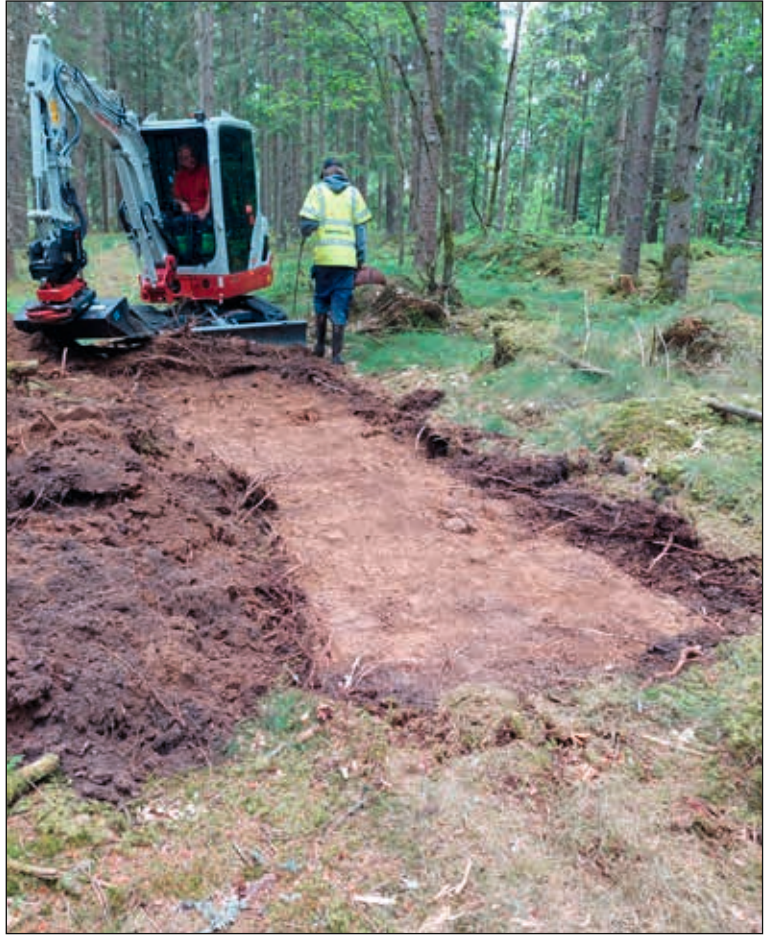
Figur 5 (t.h). Arbetsbild föreställande schakt 18.
