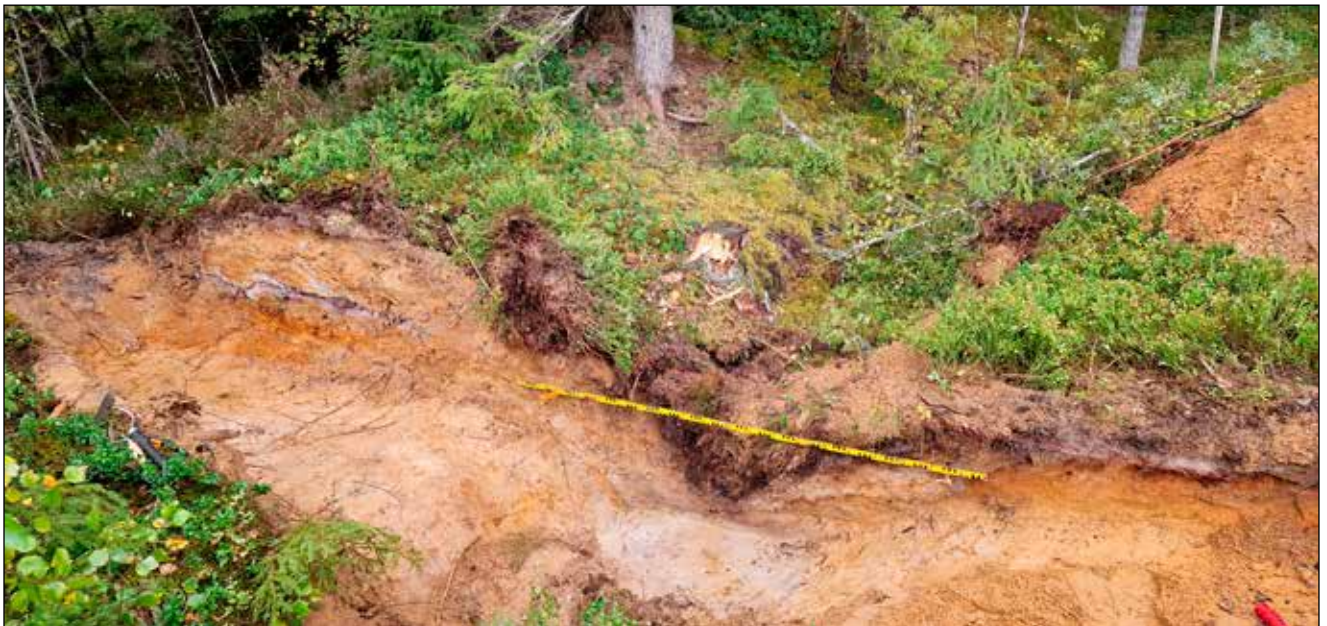
Figur 17 (nedan). Schakt 1. Profil som visar vall och dike av hägnadsvallen L2021:8011. Foto mot sydväst.
