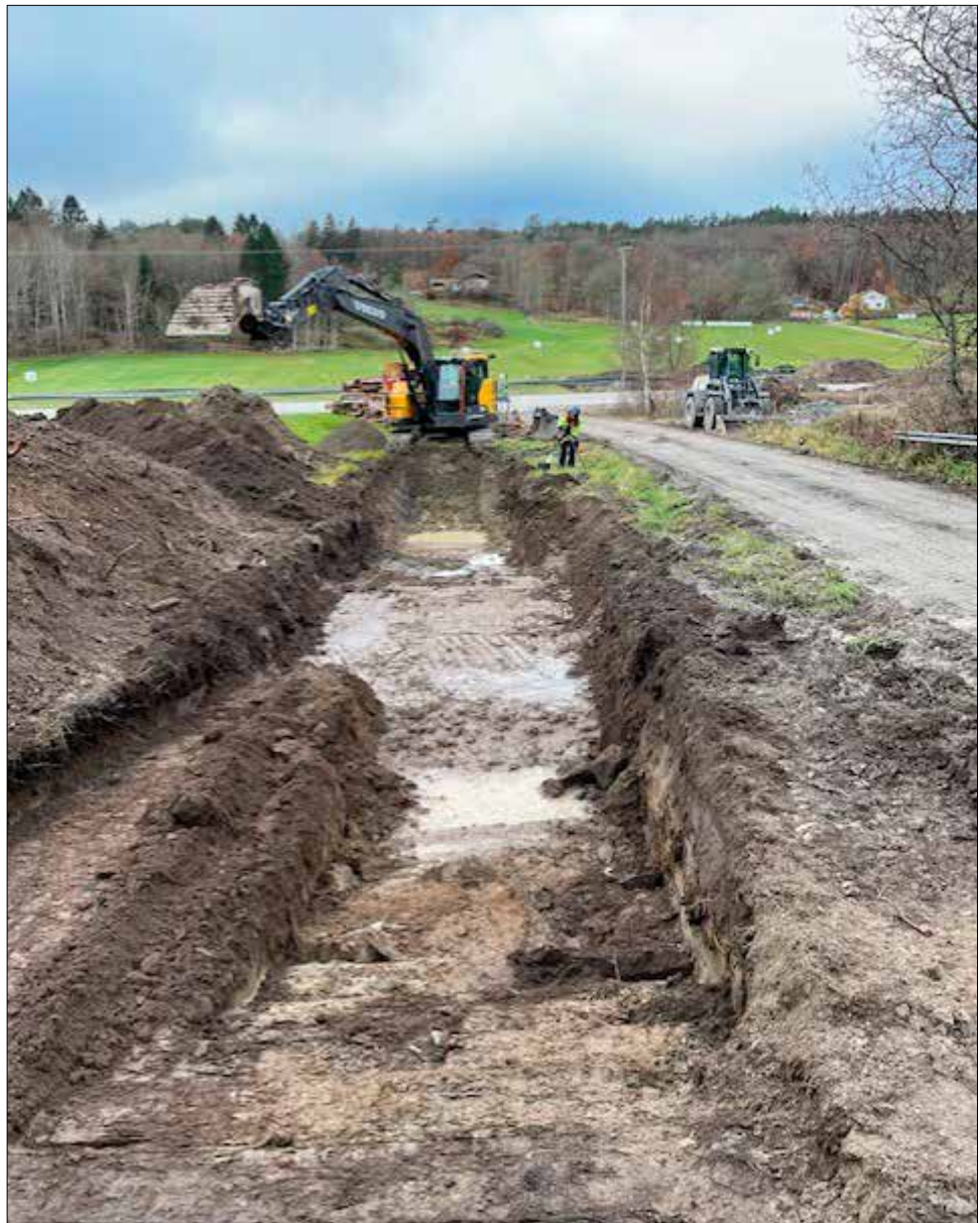
Figur 27 (t.h). Foto över S105, S111 och djupschakten S112 och S113. Foto mot nordväst.
