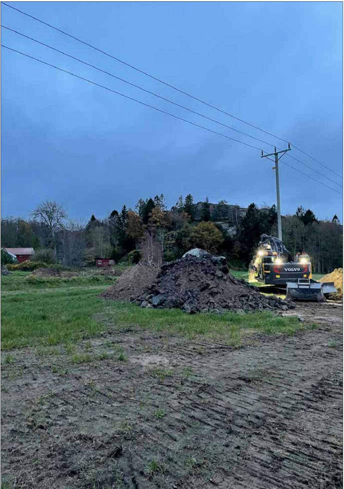
Figur 11. Schaktning pågår inom den västra delen av undersökningsytan. Foto mot sydöst.
