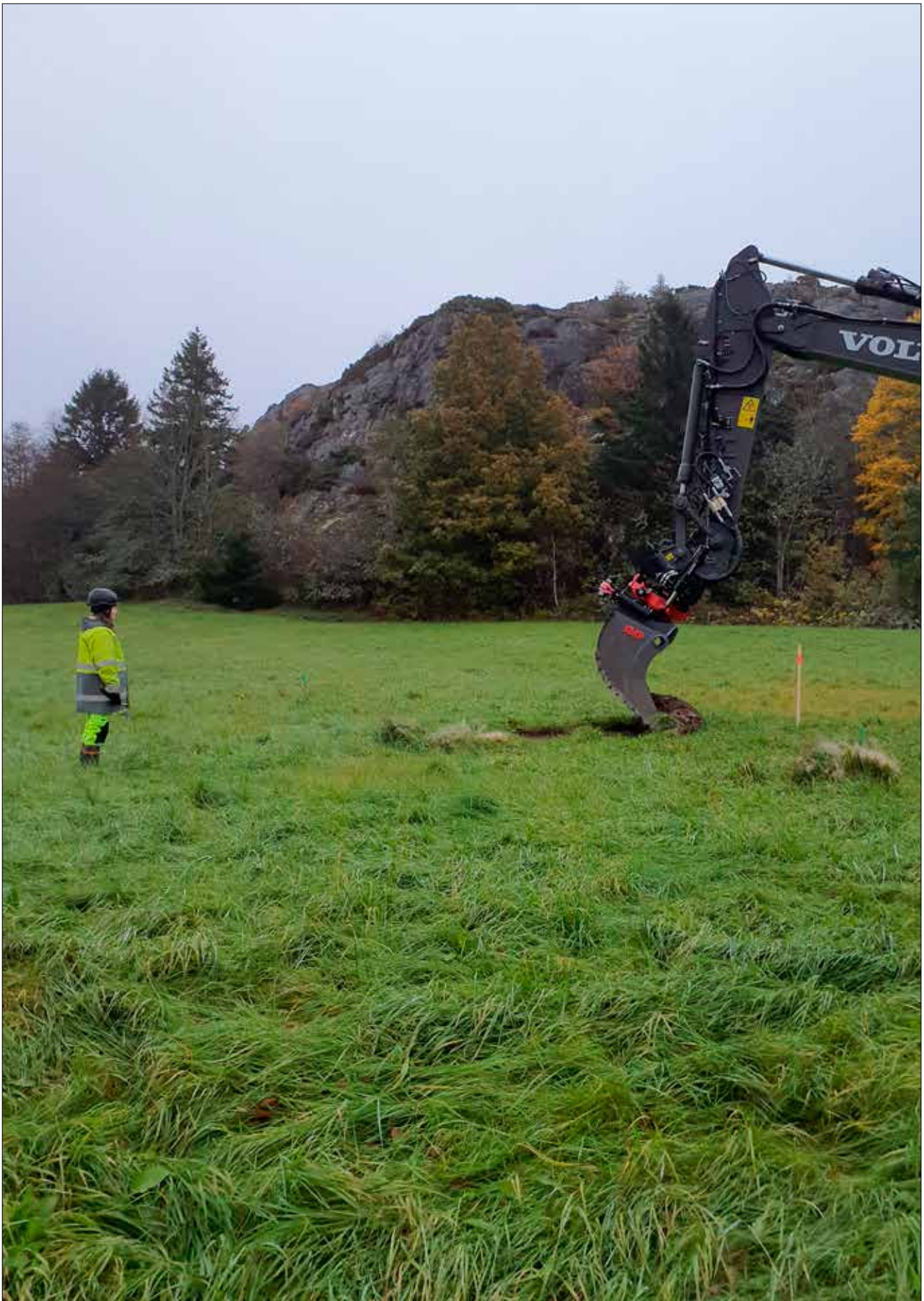
Figur 7. Schaktningen inleds på den centrala delen av L1968:2225. Berget utgör en tvär gräns åt öst för fornlämningen. Foto mot öster.
