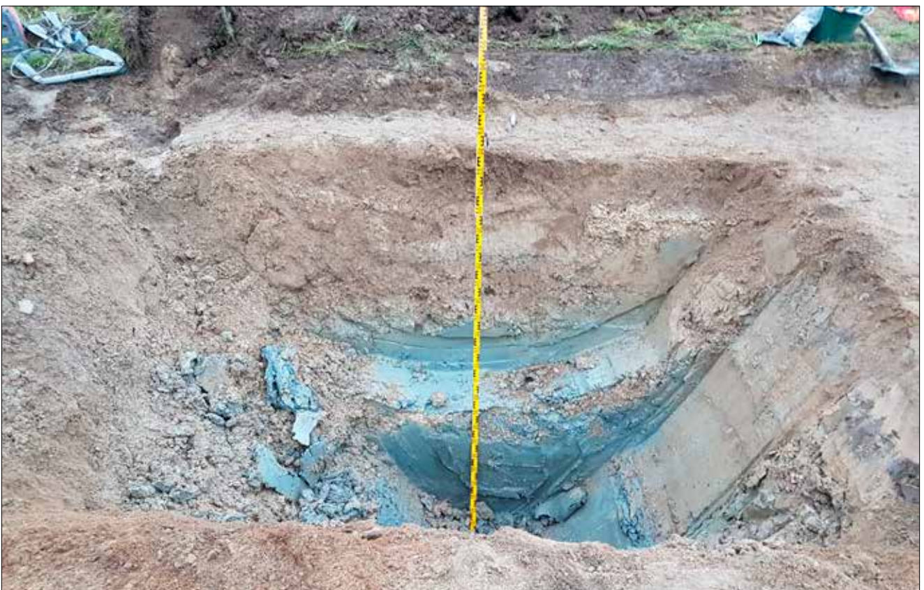
Figur 16. Djupschakt S103. Notera sandlagren ovanpå leran. Foto mot norr.
