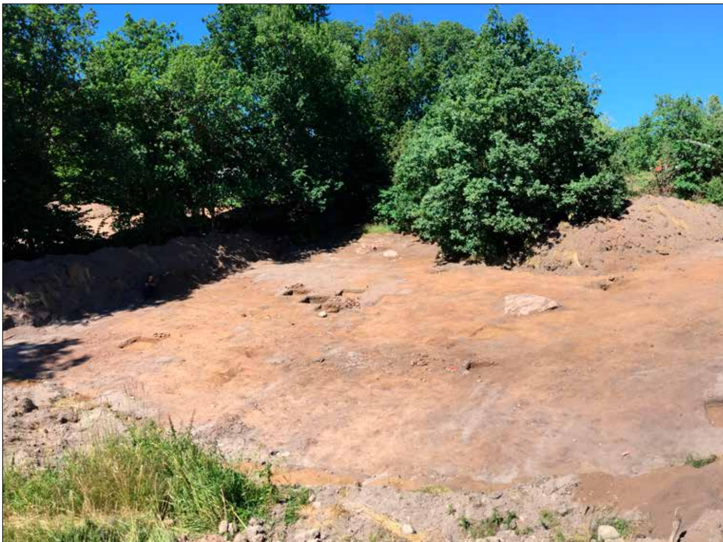
Figur 24. Översiktsbild av Yta B. Foto mot norr.
