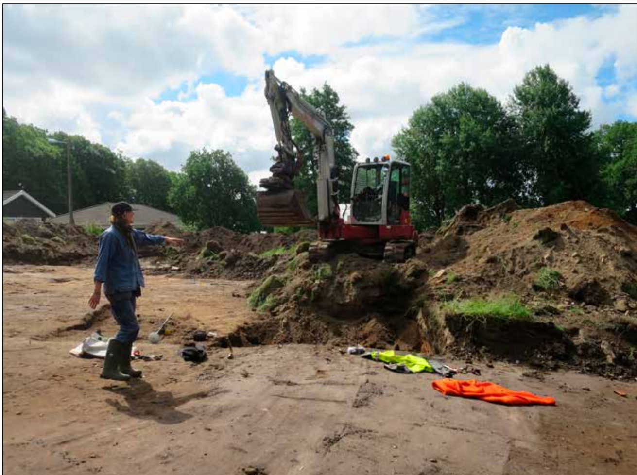
Figur 10. Djupschakt vid infiltrationsanläggningen inom L1970:7105.
