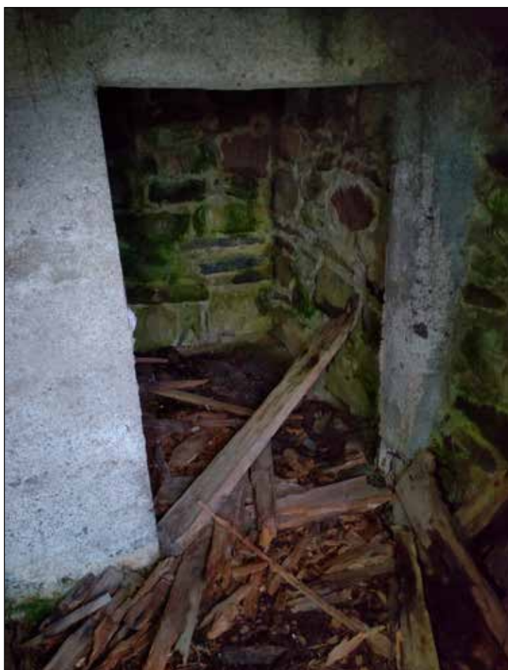
Figur 39 (ovan). Jordkällaren vid Soldattorpet (ST) vid Grønnemossen (lägenhetsbebyggelsen L2025:858) var ingrävd i en liten gruskulle och hade gjutna element och en bevarad trädörr. En välbevarad hägnad löper längs med en lite bruksväg som leder fram till husgrunderna för torpet. Foto mot nordost.
