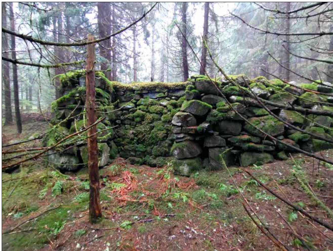
Figur 30. En av husgrunderna vid torpet Nytorp (lägenhetsbebyggelse L2025:854) var intakt och imponerande i sin utformning. Grundmuren mätte över två meter i höjd och var anlagd mot och på ett bergsimpediment. Foto mot sydväst.
