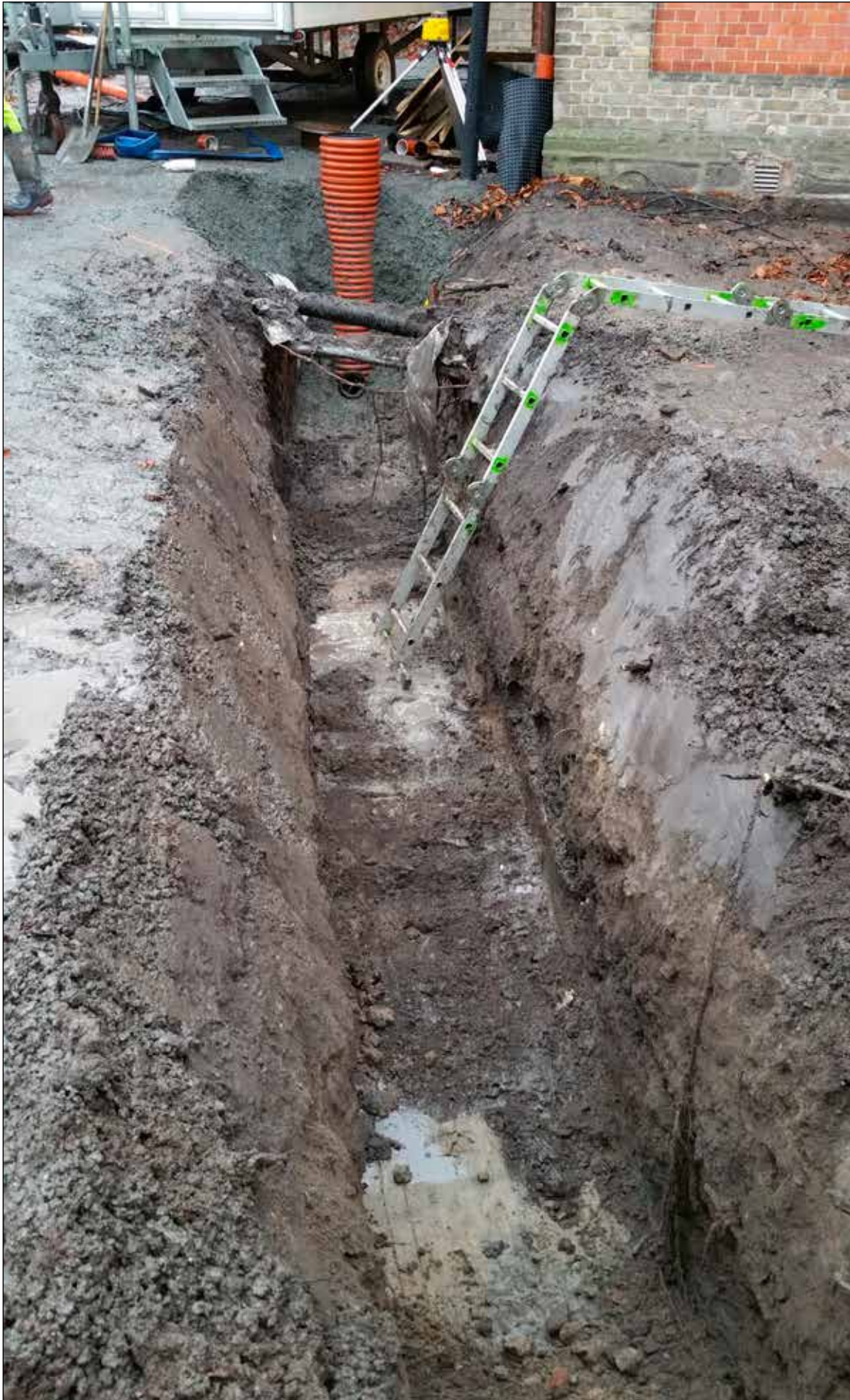
Figur 52. Södra delen av Schakt 4:1. Foto mot syd.
