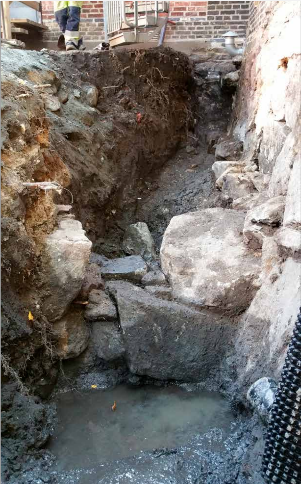
Figur 9. Schakt 1 med den norra muren mot nordväst.
