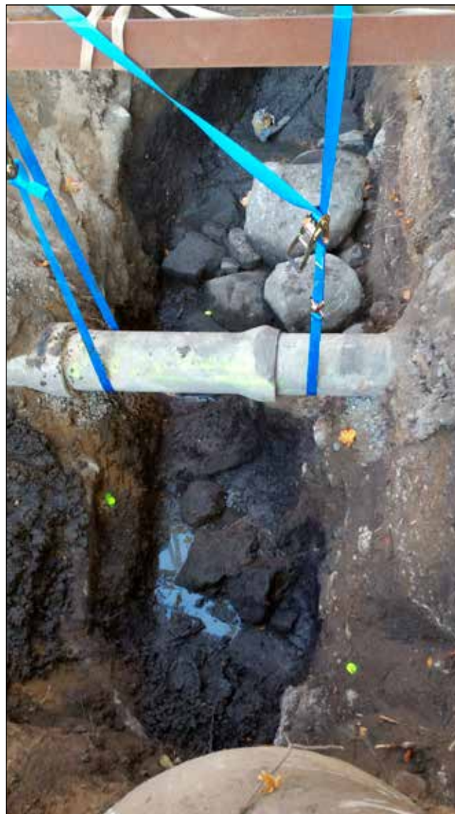
Figur 27. Schakt 3. Översikt av mur i schaktets nordvästra del. Foto mot nordost.
