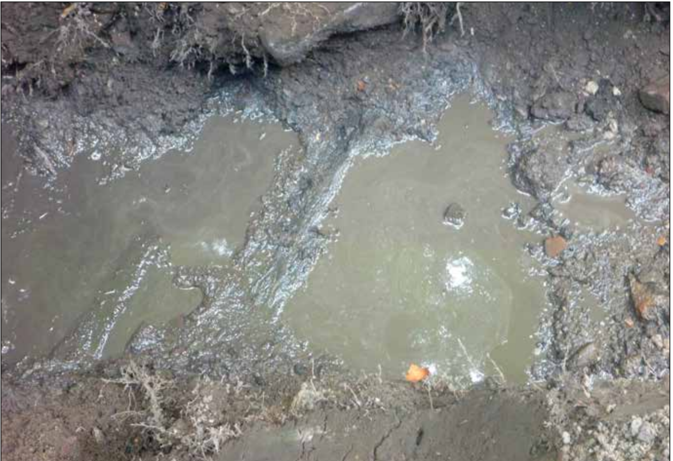
Figur 8 (nedan). Schakt 1 med den södra muren och rustbädden mot sydväst. Rustbäddsstockar syns i botten av schaktet. I fotot syns en större sten från den mur som legat på rustbädden.
