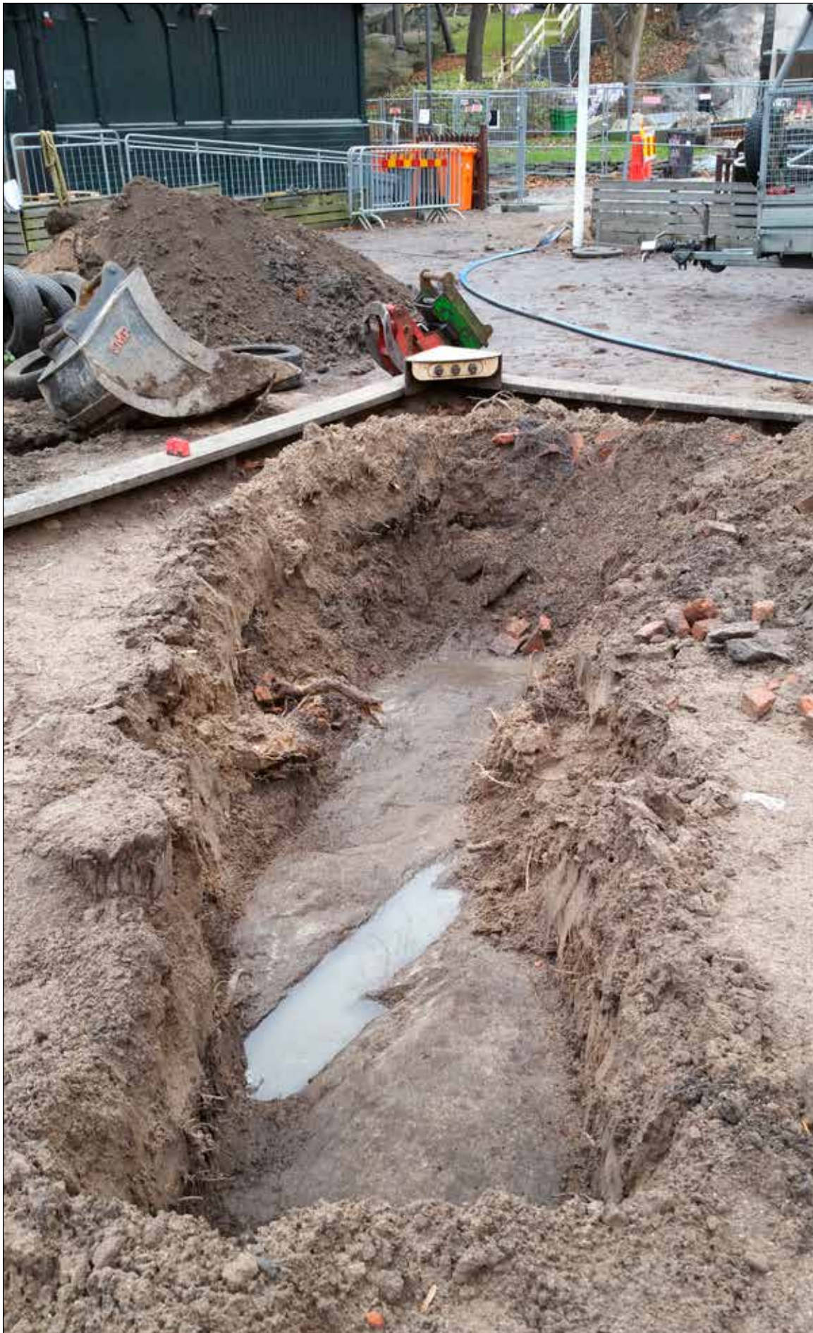
Figur 31. Provgrop 5. Foto mot nordväst.
