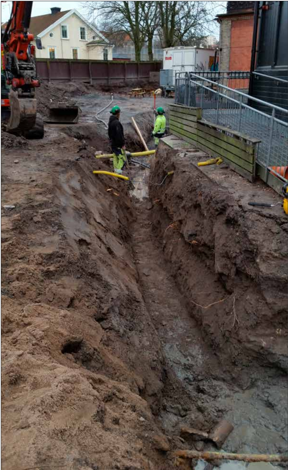
Figur 56. Översikt av Schakt 4:2 och södra delen av Schakt 4:3. Foto mot syd.
