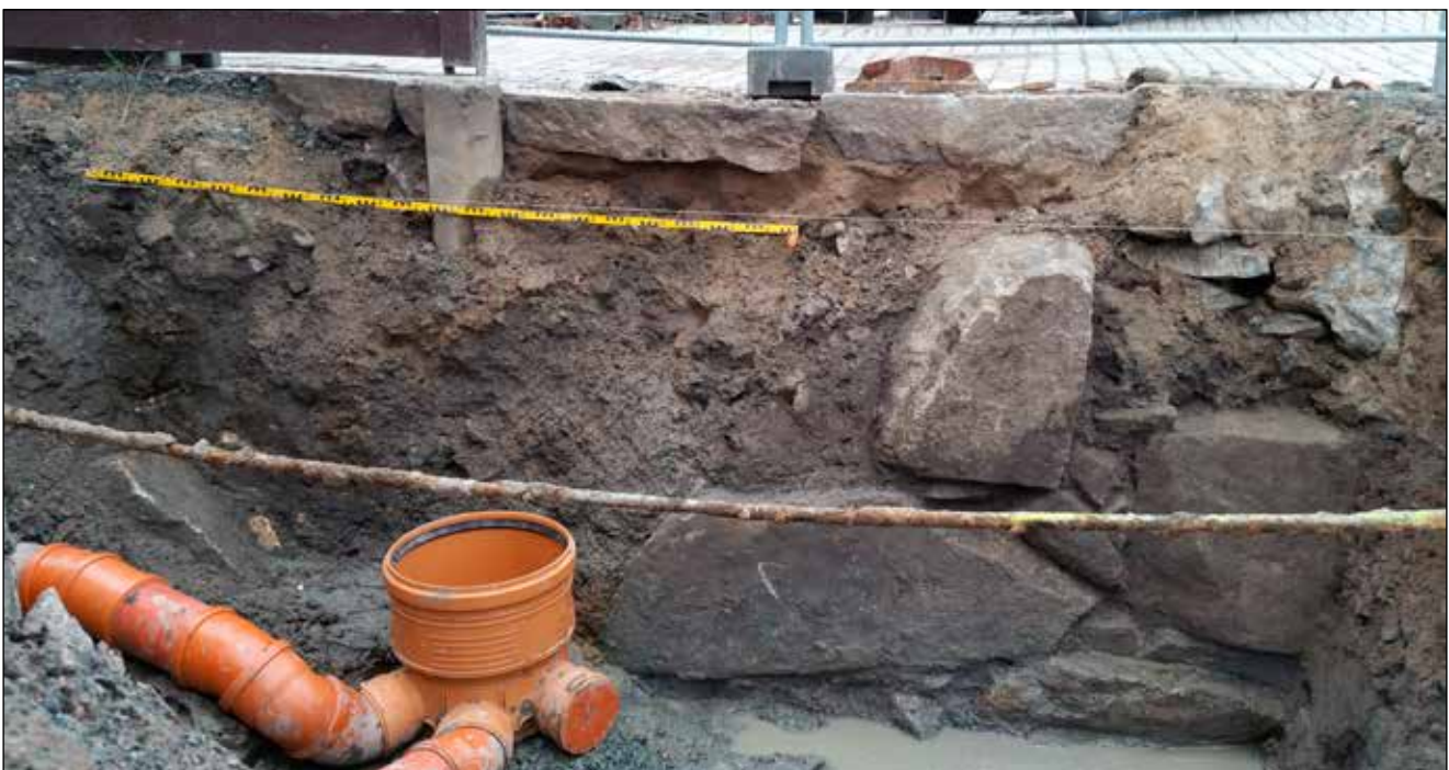
Figur 58. Norra änden av Schakt 4:3 med rester av stenmur. Foto mot norr.
