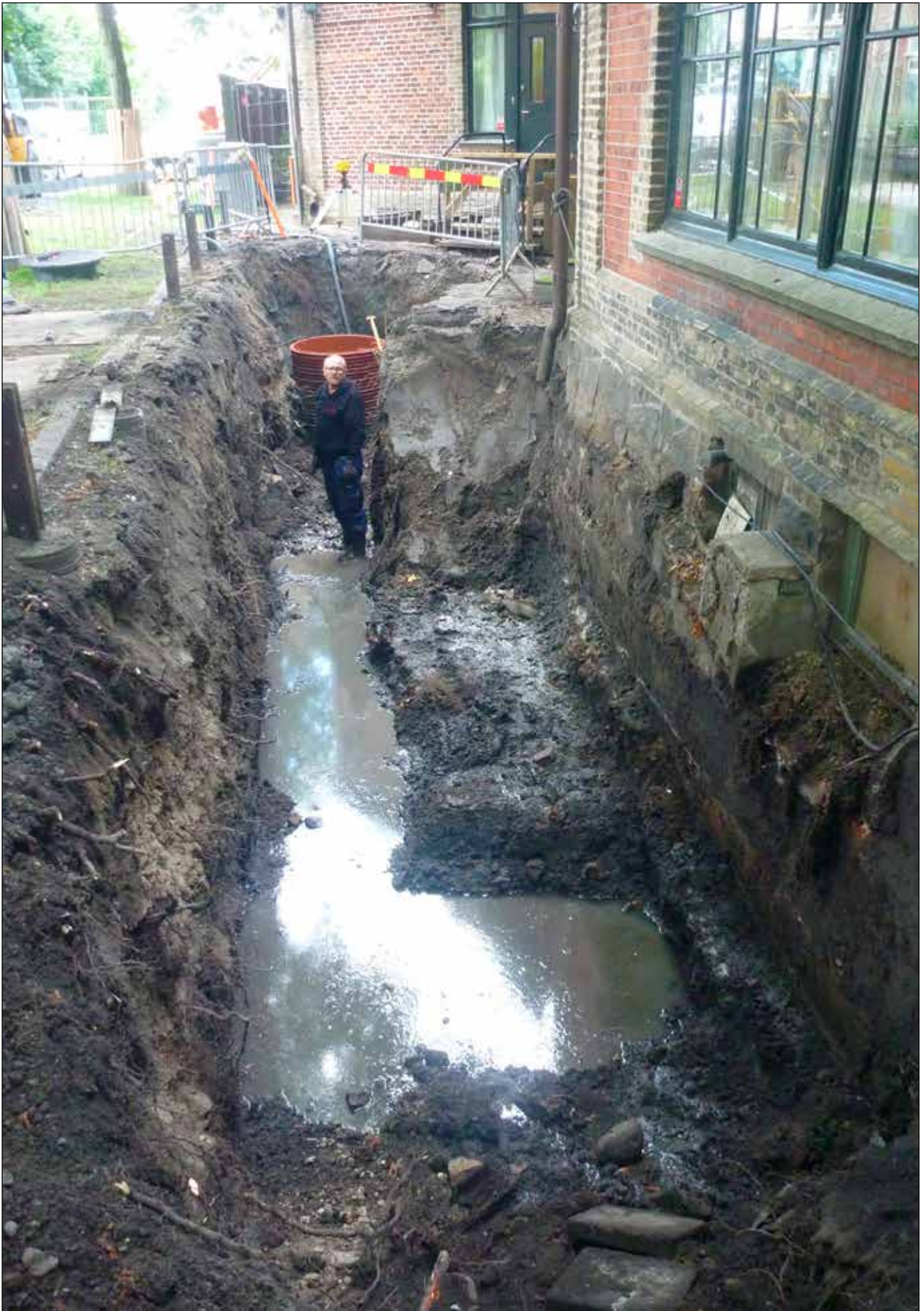
Figur 6. Schakt 1. Mats stående i Schakt 1, översikt mot nordväst.
